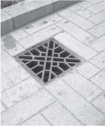
Dækslers og ristes mål bør passe med belægningens byggemål eller skifter. Foto: Torben Dam.
